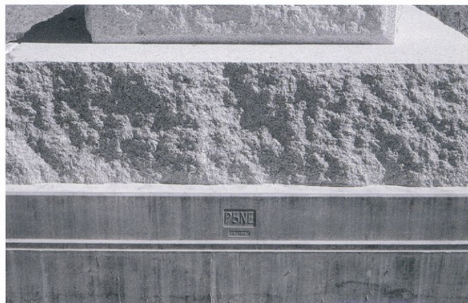
Interfase H [100N/mm 2 ]. Timbrado posición-orientación [H-1000]. Interface H [100N/mm 2 ]. Position-orientation stamp [H-1000].
