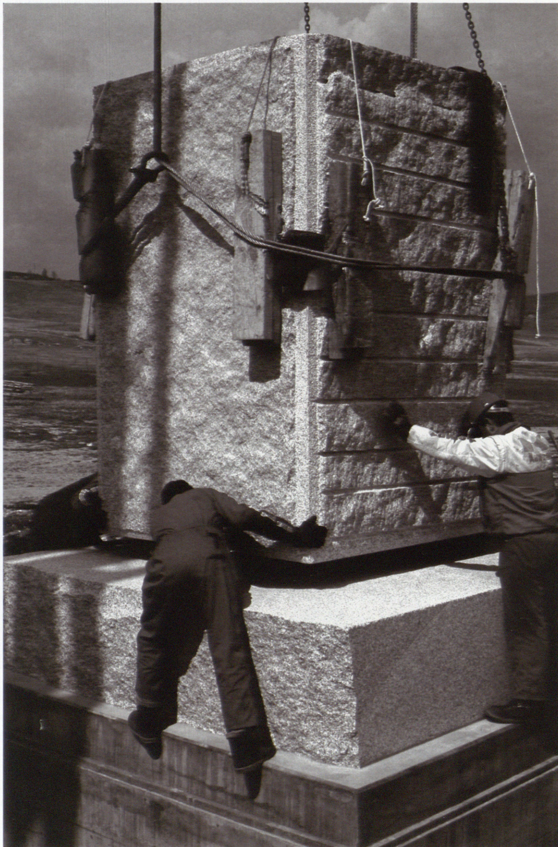
Montaje en posición de Pilas de Apoyo. Granito berroqueño 30T. Grúa de precisión Liebherr LTM 1160/1 180T. A stone pier going in pedestal position. Berroqueño's granite 30 T. Accuracy crane Liebherr LTM 1160/1 180T.
